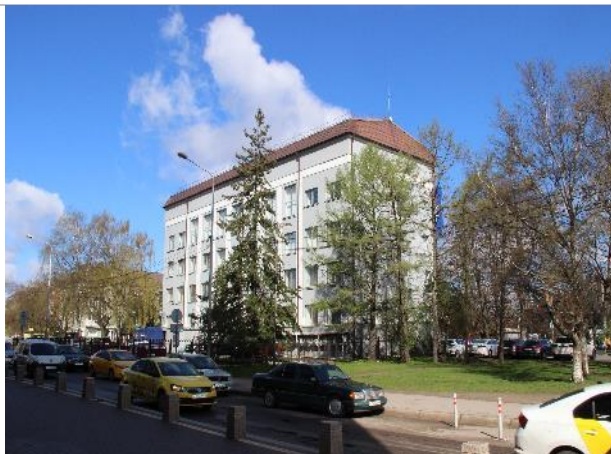
Фотография 5. Внешнее состояние объекта.
