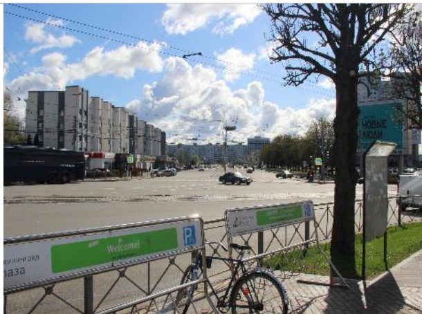
Фотография 6. Внешнее состояние объекта.
