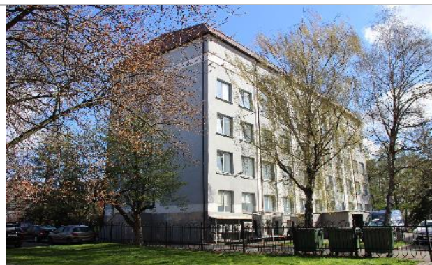
Фотографияграфия 3.1. Внешнее состояние объекта
