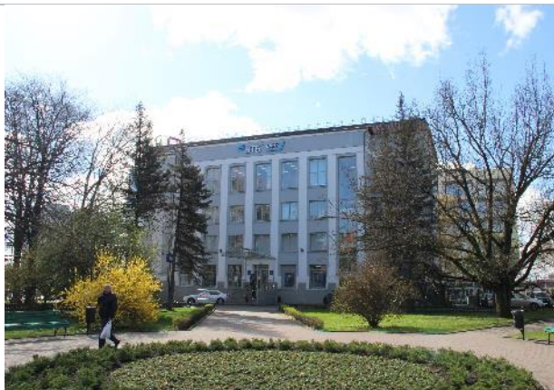
Фотография 1. Внешнее состояние объекта.
