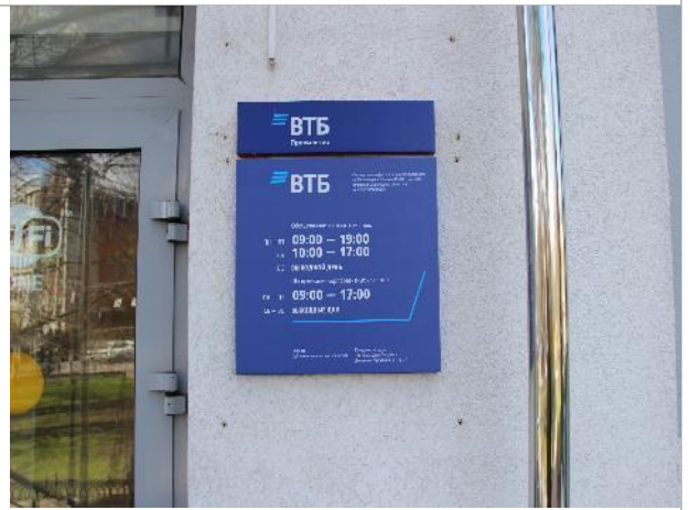
Фотография 12. Внешнее состояние объекта.
