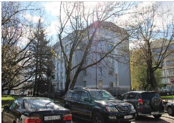
Фотография 2. Внешнее состояние объекта.
