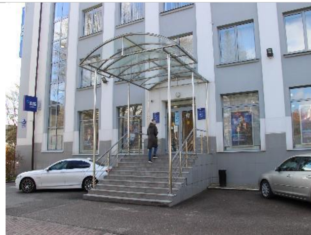
Фотография 11. Внешнее состояние объекта.
