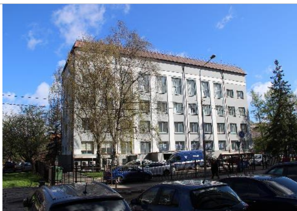
Фотография 4. Внешнее состояние объекта.
