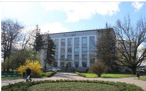
Фотографияграфия 3.2. Внешнее состояние объекта
