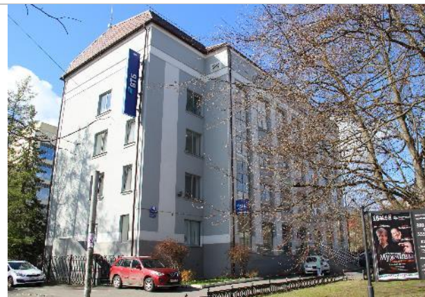
Фотография 9. Внешнее состояние объекта.
