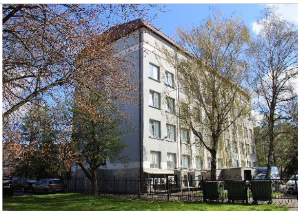
Фотография 3. Внешнее состояние объекта.
