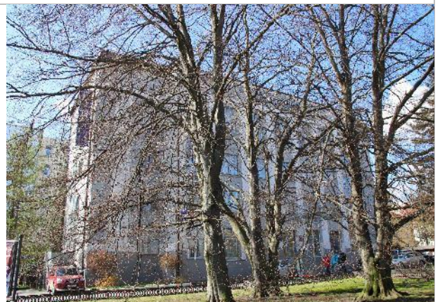
Фотография 10. Внешнее состояние объекта.
